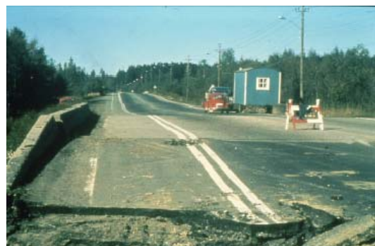
ภาพที่ 1 การทรุดตัวของสะพานในประเทศนอร์เวย์ (SveinAlfheim, 2011)
