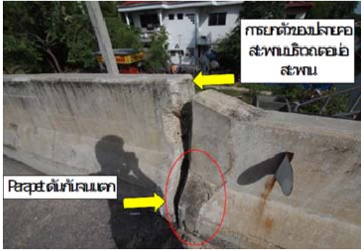
ภาพที่ 2 การทรุดตัวของคอสะพานทำให้ร้าวกันแตกแยกตัว (สมโพธิ อยู่ไว, 2554)
